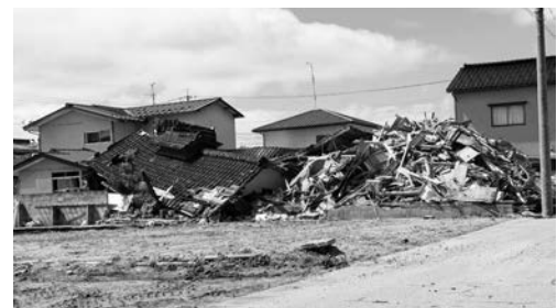
撮影当時、いまだに倒壊したままの家屋
